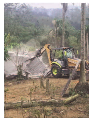
Casas foram demolidas
