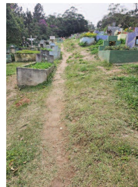
Espaço não tem pavimentação
