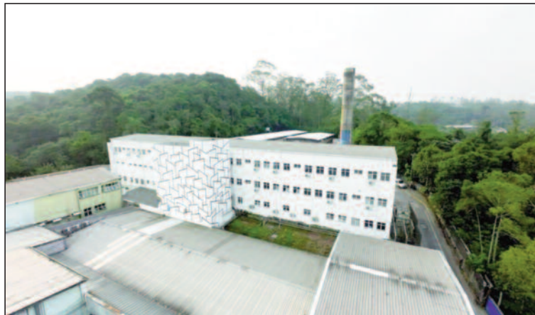
Hospital São Lucas - Santa Luzia será inaugurado no próximo dia 20
